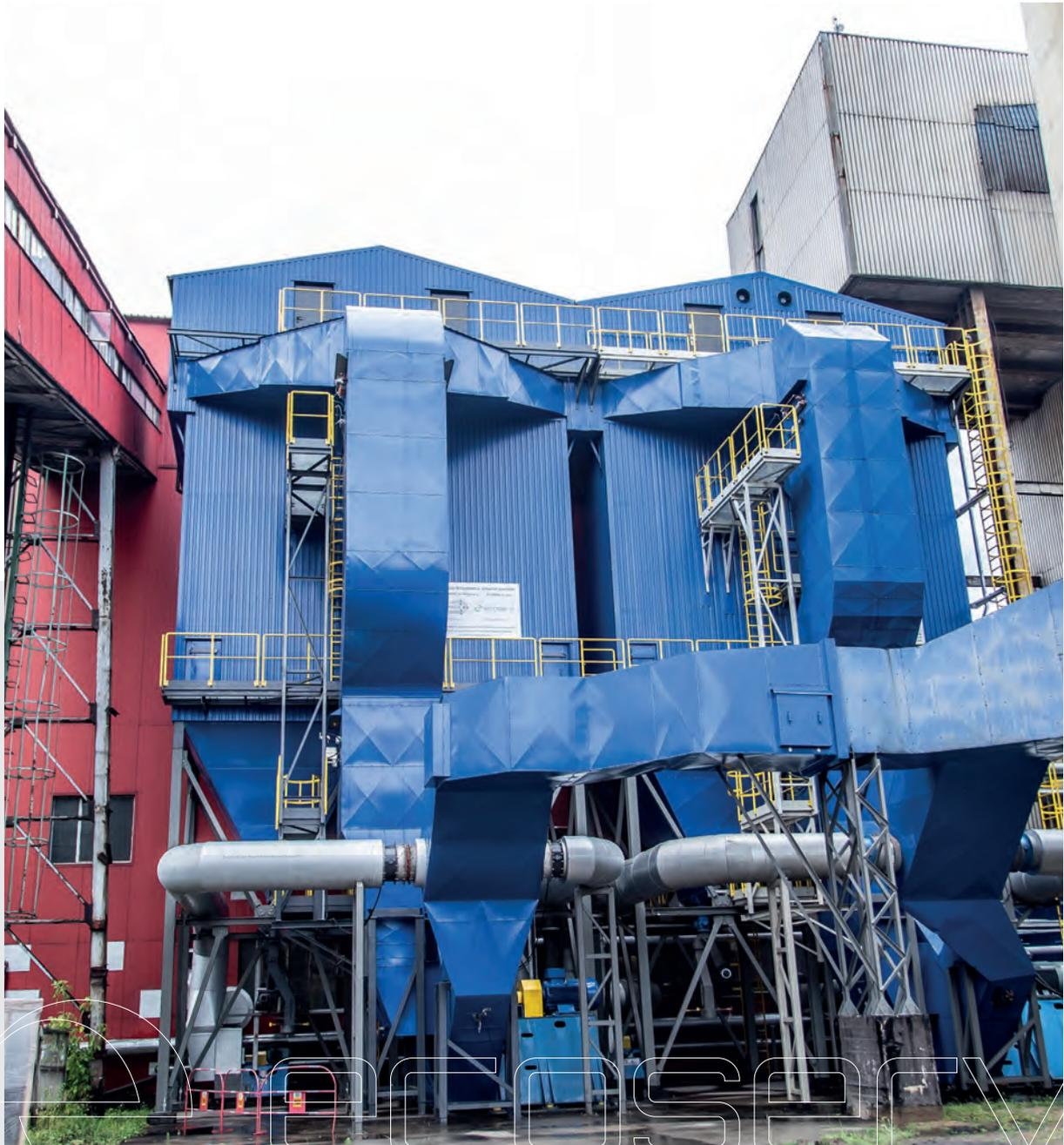
tergewebes. Die gepulste Luftregeneration des Filters erfolgt zyklisch (die Zeit zwischen den Druckluftimpulsen wird eingestellt) oder automatisch (wenn die Druckdifferenz den in der Filtersteuerung eingestellten Wert überschreitet).
