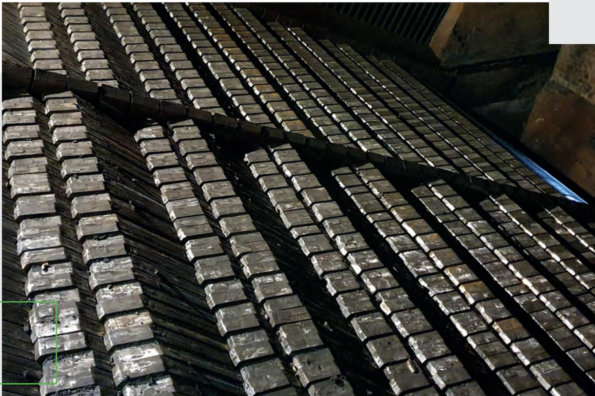
Die Biomasse wird auf die oberste Ebene des Rostes befördert und dann während des Verbrennungsprozesses mit Hilfe eines hydraulischen Systems in einer Hin- und Herbewegung allmählich auf die unteren Ebenen befördert. Durch diese Anordnung lässt sich der Verbrennungsprozess besser steuern und eine gleichmäßige Verteilung der Biomasse auf dem Rost gewährleisten.
